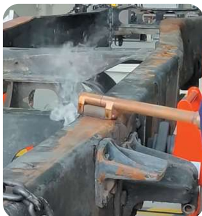
Narovnání konstrukce těžkého vozidla induktor Large L90 Powerduction 220LG
